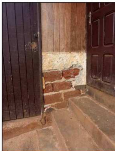
Brique crue Soubassement en brique crue
