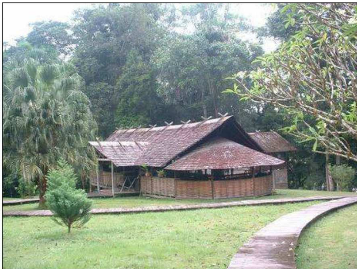
Exemple de toiture avec bardeaux en milieu équatorial. La durée de vie est estimée à plus de 30 ans.
