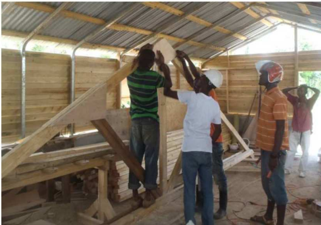
Exemple de montage en atelier
