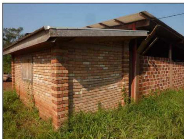
Bâtiment prototype (SFID) Poteaux d'angle en maçonnerie de brique
