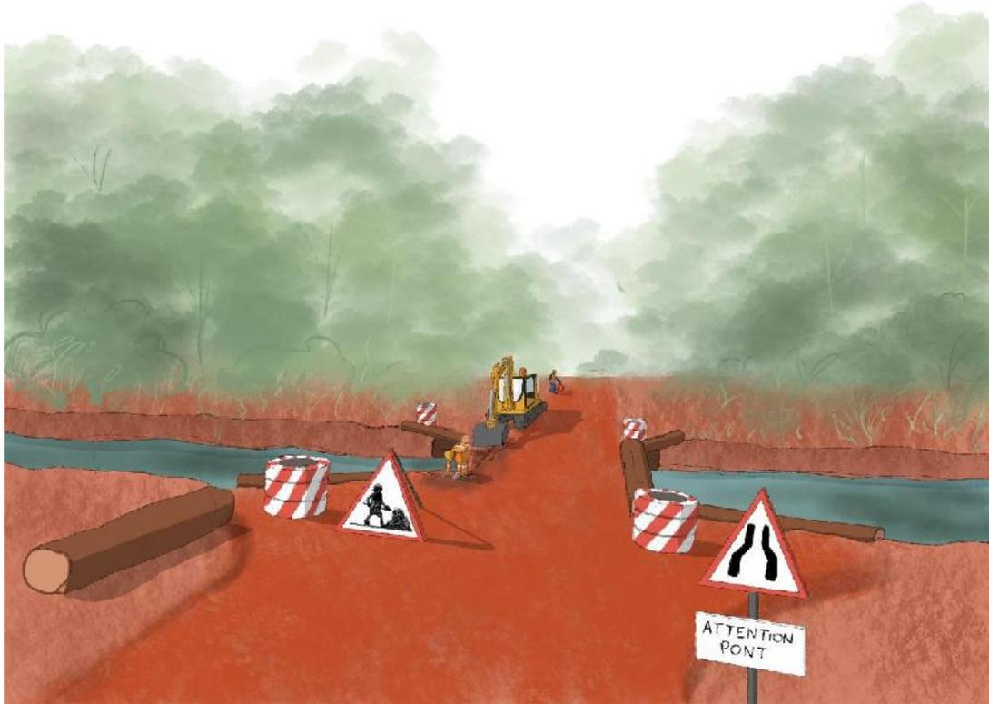
5.6-DES-02 : Exemple de signalisation routière en chantier routier
