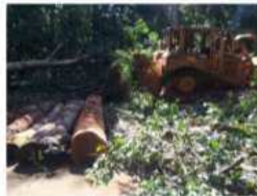
Faire traverser les engins sur les rondins d'une berge à l'autre sans apporter de terre dans la rivière tout en permettant de maintenir l'écoulement naturel de la rivière.
