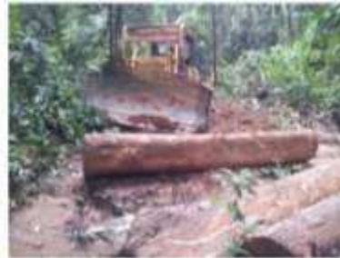
Pousser progressivement les rondins (5m) dans le lit de la rivière en veillant à ne pas apporter de la terre
