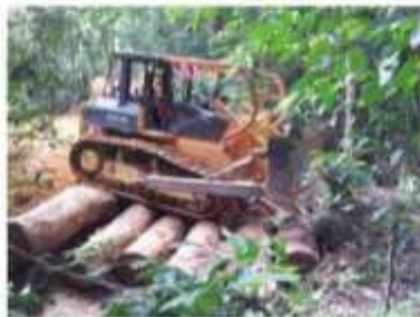
Faire traverser les engins sur les rondins d'une berge à l'autre sans apporter de terre dans la rivière tout en permettant de maintenir l'écoulement naturel de la rivière.
