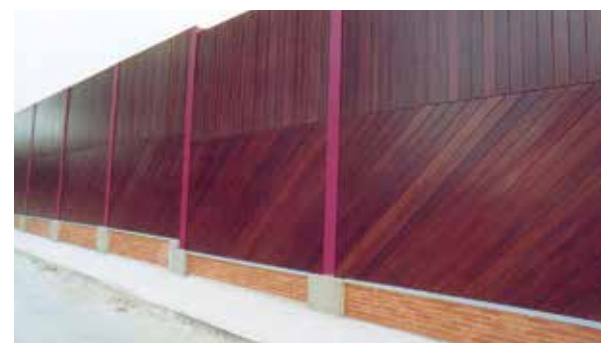
▼ Photo 64 : Ecrans acoustiques réfléchissants sur voie routière © M. Vernay
