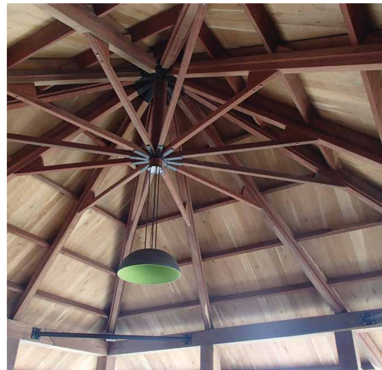
▲ Photo 27 : Charpente © P. Martin, ATIBT
