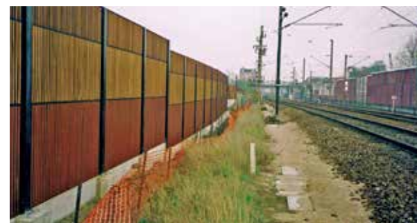
▲ Photo 65 : Ecrans acoustiques absorbants sur voie de chemin de fer © M. Vernay
