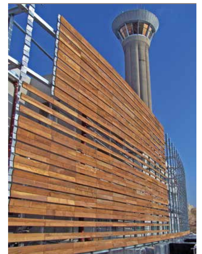
▲ Photo 39 : Façade brise soleil en Iroko © M. Vernay
