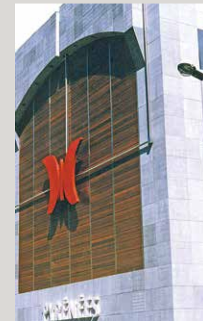
▲ Photo 34 : Aménagement de façade en bardage bois © M. Vernay
