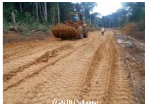
Compactage au compacteur mixte (à gauche) au chargeur à pneus (à droite)
