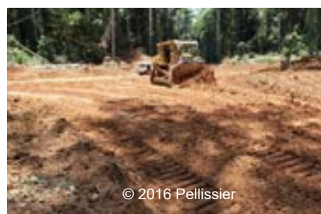
Nivellement de la route en construction (à gauche) Phase de préparation de la banquette (à droite)
