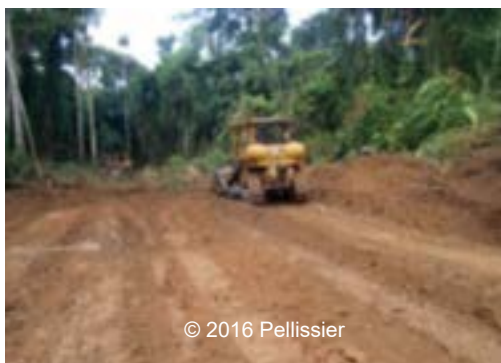
Décapage et réglage sommaire de la chaussée (à gauche) et sortie des matériaux des exutoires (à droite)
