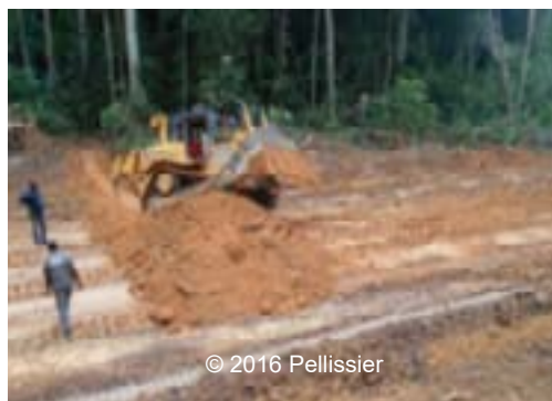
Décapage et réglage sommaire de la chaussée (à gauche) et sortie des matériaux des exutoires (à droite)
