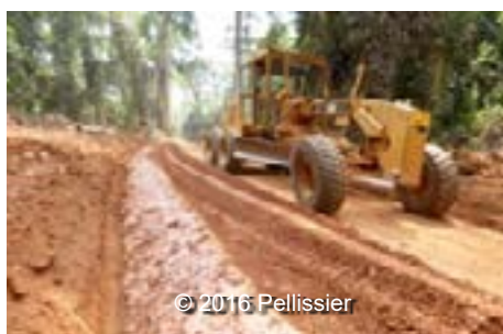
Nivellement de la route en construction (à gauche) Phase de préparation de la banquette (à droite)
