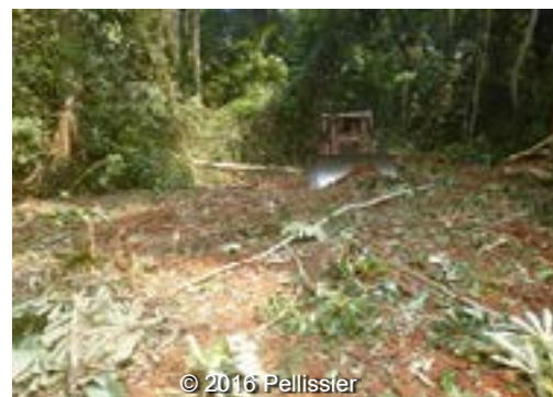
Déboisement d'un parc au bulldozer
