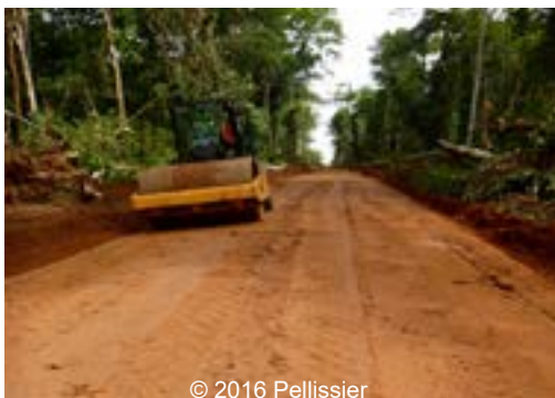
Compactage au compacteur mixte (à gauche) au chargeur à pneus (à droite)
