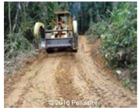
Fermeture du terrassement d'une bretelle à l'aide de la fourchette
