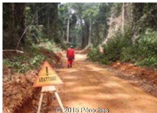
Un chantier bien balisé
