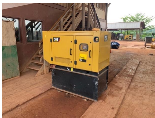
Groupe électrogène avant son installation
