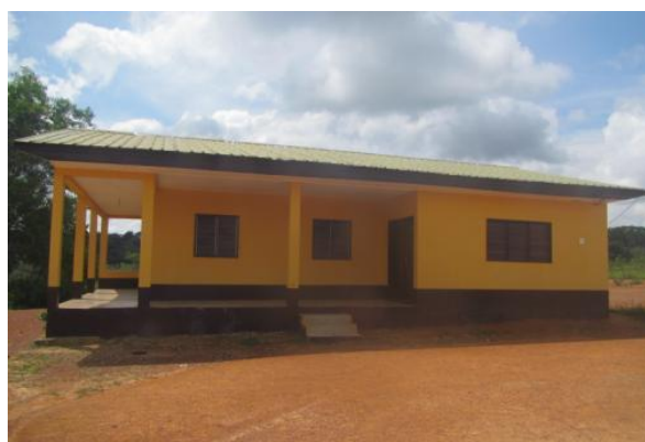
Bureaux de Brigade Faune de Ndangui entièrement rénové par PW-CEB
