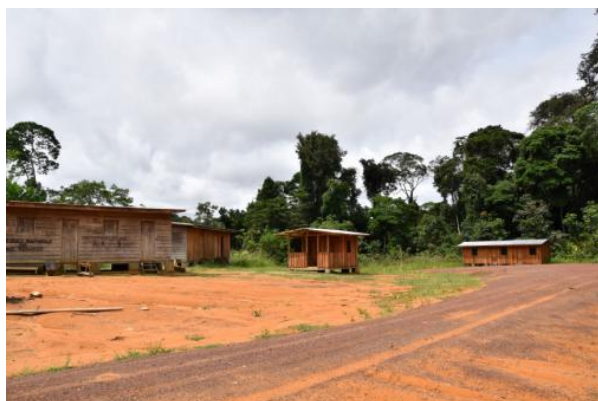
Camp éco-gardes de l'ANPN à Milolé Entièrement réhabilité par PW-CEB
